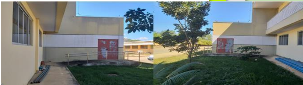
Figura 2G. Portas de emergência, tipo corta-fogo, localizadas dentro dos auditórios. Fonte: Própria do autor.
