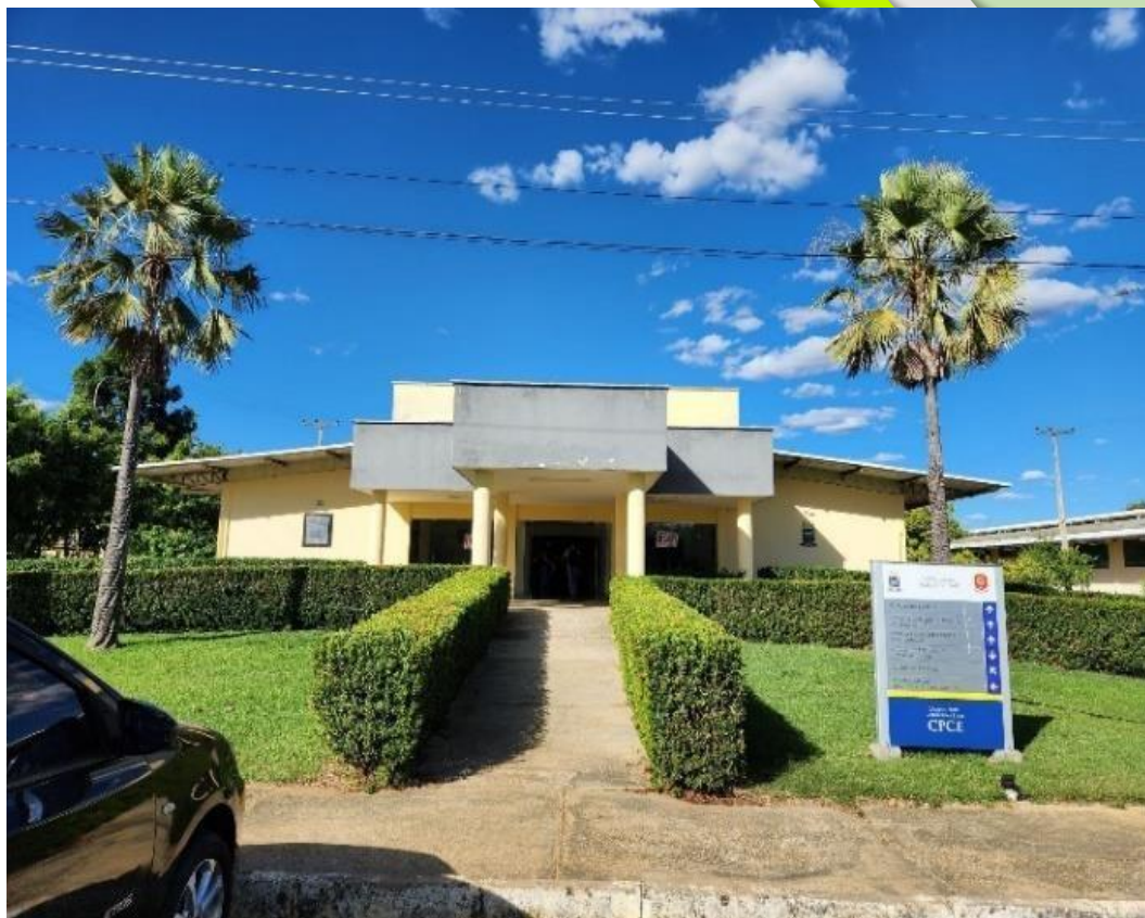
Figura G. Entrada para acesso ao bloco 103. Fonte: Os autores, 2024.
