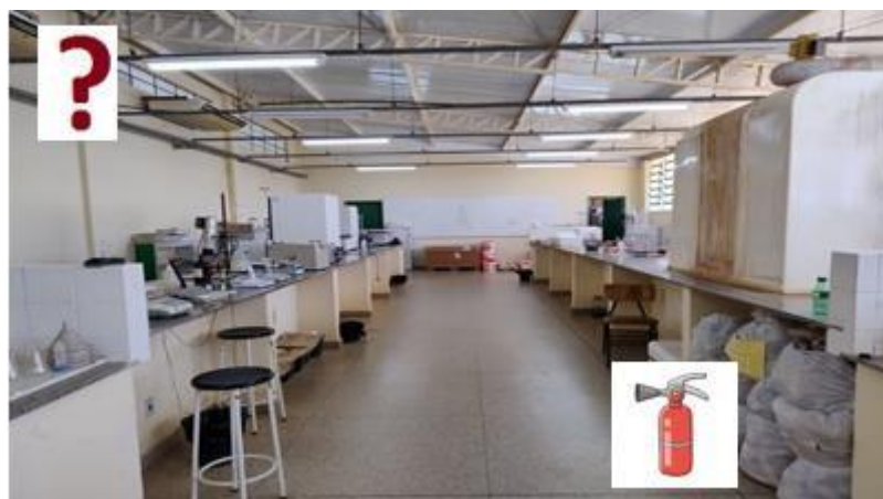
Figura 20. Instalação de Extintores do tipo B e C em cada laboratório. Fonte: Os autores, 2024.
