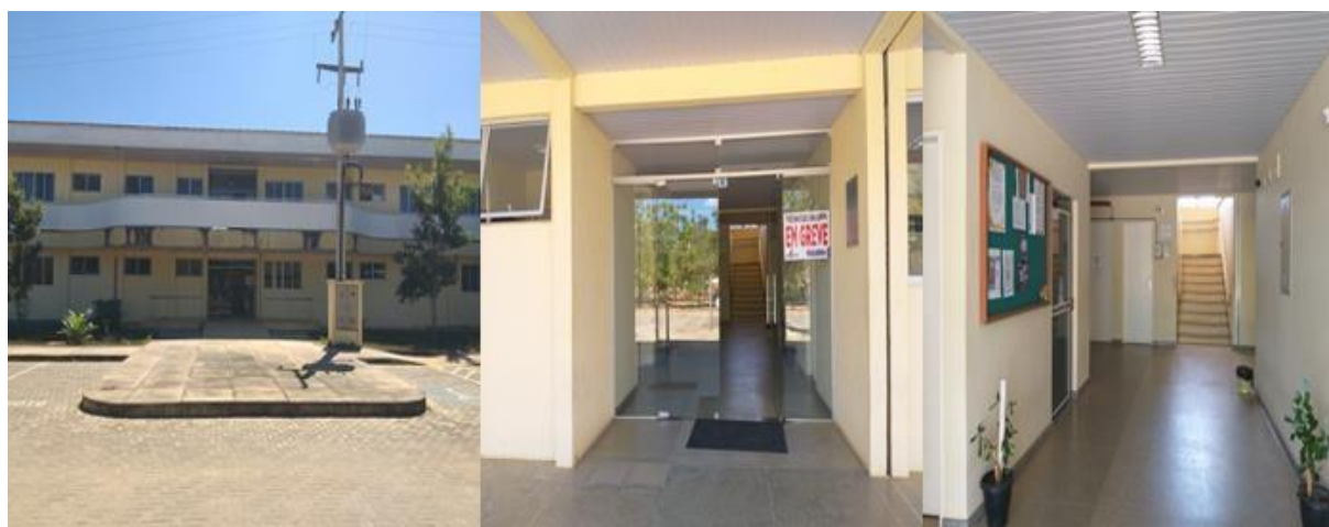
Figura 28. Fachada e acesso para entrada e saída do prédio da pós-graduação. Fonte: Os autores, 2024.
