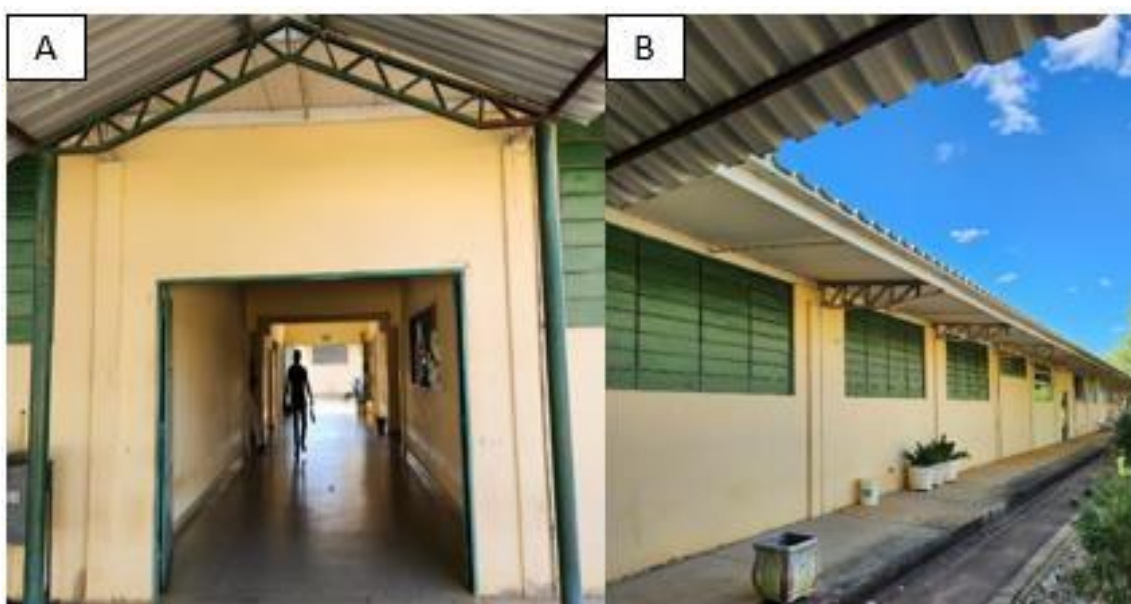
Figura 12. (A) Entrada/Saída lateral do bloco 103; (B) Lateral do bloco. Fonte: Os autores, 2024.
