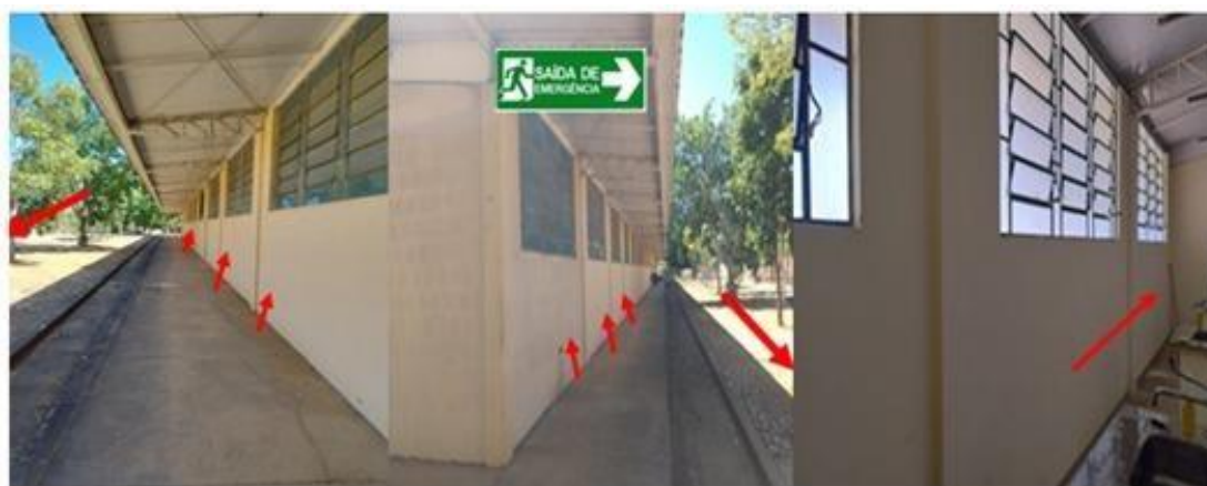
Figura 18. Construção de portas de emergência com saída na lateral em todos os laboratórios formando uma rota de fuga. Fonte: Os autores, 2024.
