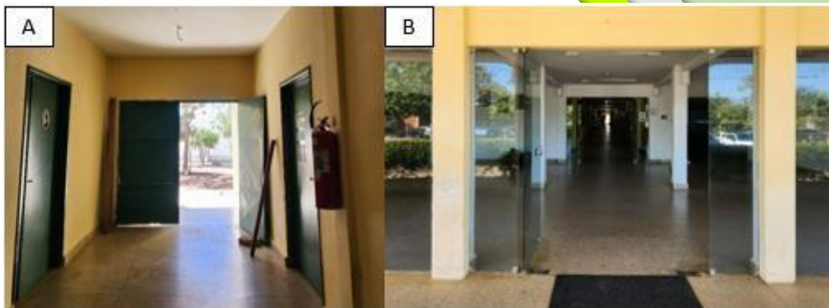
Figura 10. (A Entrada/Saída fundo do bloco); (B) Entrada/Saída principal do bloco 103. Fonte: Os autores, 2024.
