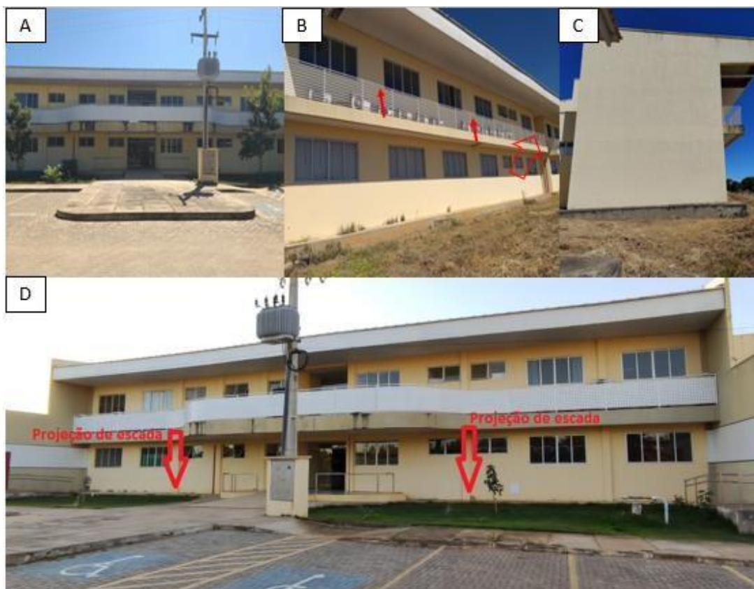
Figura 30. Indicação dos locais para a construção das escadas de saída de emergência. (A) Entrada principal com ausência da escada; (B) Setas indicando possíveis locais para a instalação de portas de emergência e a construção de uma escada na parte de trás do prédio; (C) Lateral do prédio sem saída de emergência; (D) Setas indicando possível local para a construção das escadas. Fonte: Os autores, 2024.
