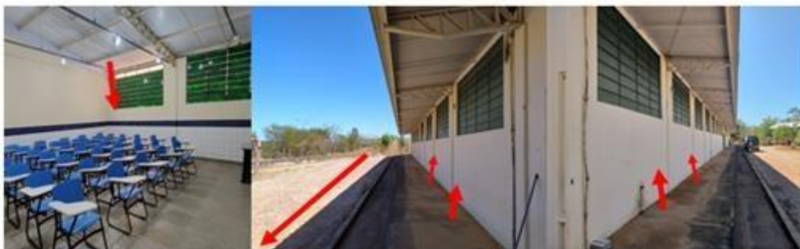
Figura 6. Construção de portas de emergência nos fundos das salas de aula, formando uma rota de fuga. Fonte: Os autores, 2024.
