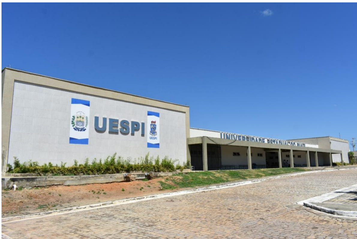
Fotografia 61 – Prédio próprio da Uespi/CPBA, no bairro Altamira, em Picos
