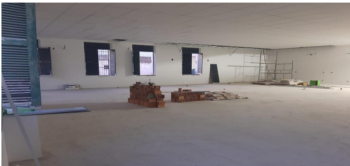
Figura 32-Interior do Prédio do GEAP modificado
