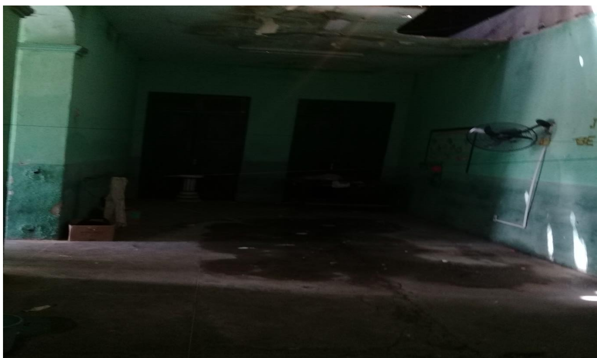
Figura 53-Interior do Prédio do GEAP original
