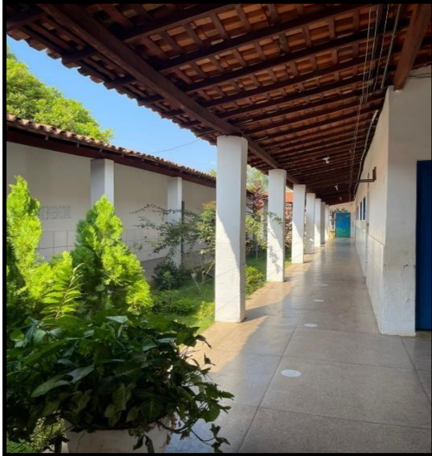
Figura 8 – Acesso às salas de aula da Escola Municipal Mata Atlântica
