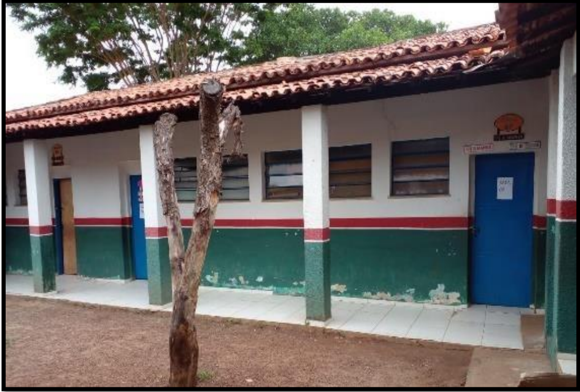
Figura 9 – Acesso às salas de aula da Escola Municipal do Cerrado
