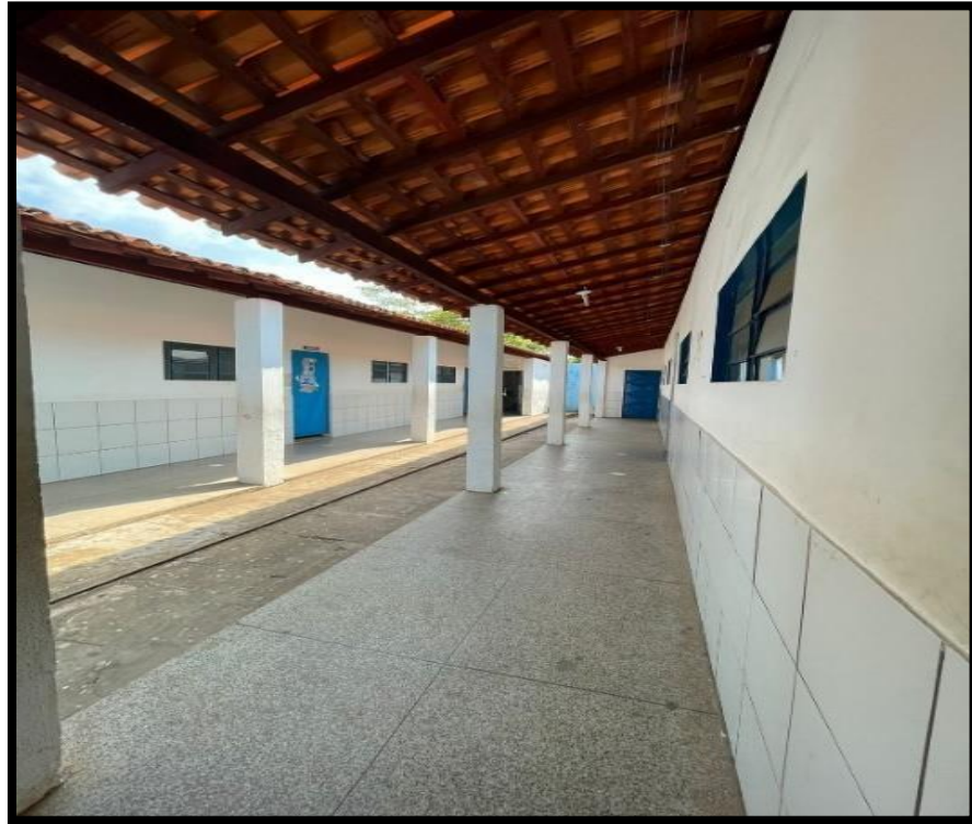
Figura 7 – Acesso às salas de aula da Escola Municipal Mata Atlântica
