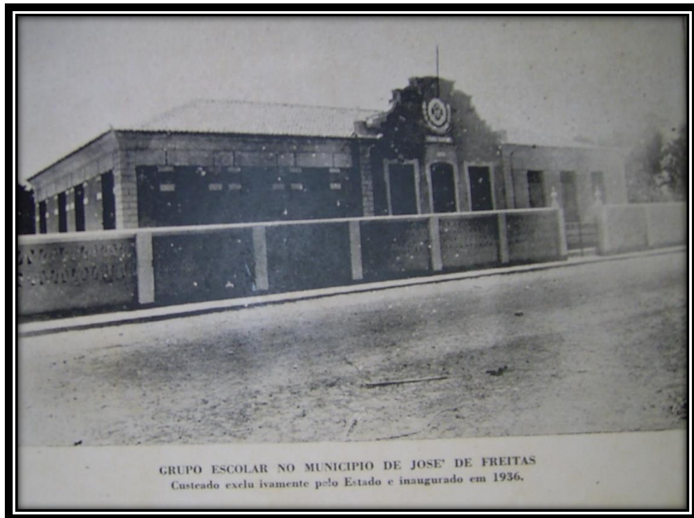
Figura 14 - Modelo de prédio de grupo escolar no Piauí
