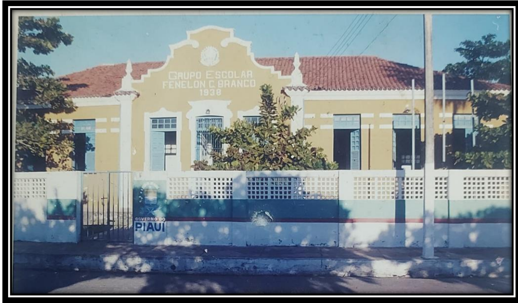
Figura 19 – Prédio do Grupo Escolar Fenelon Castelo Branco, em União (PI)
