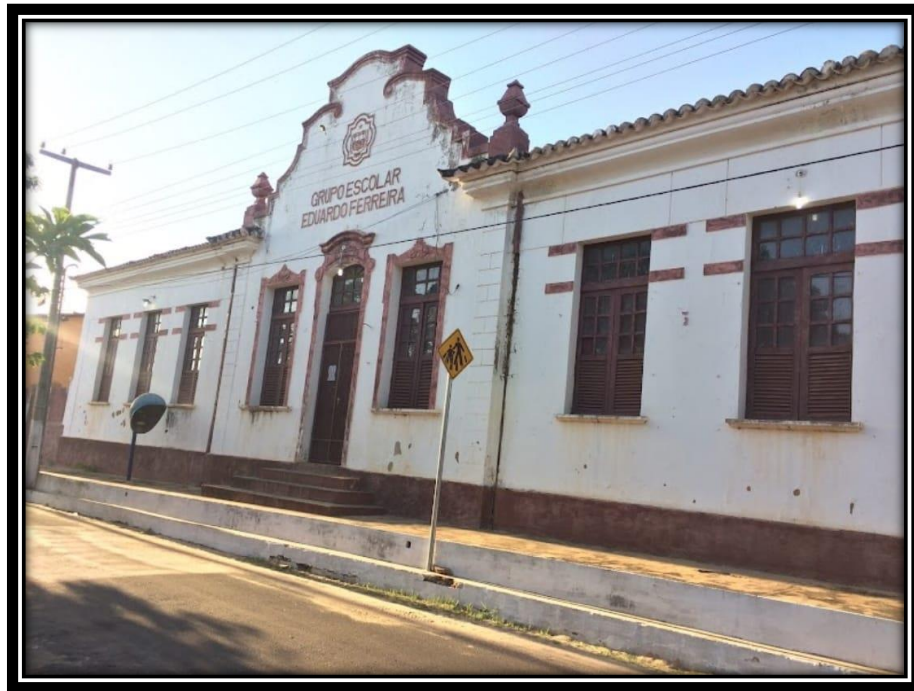
Figura 15 - Prédio do Grupo Escolar Eduardo Ferreira, em Amarante (PI)
