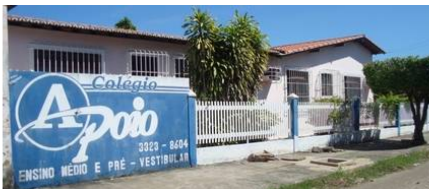
Figura 05: Fachada do Colégio Apoio Fonte: Arquivo pessoal da pesquisadora
