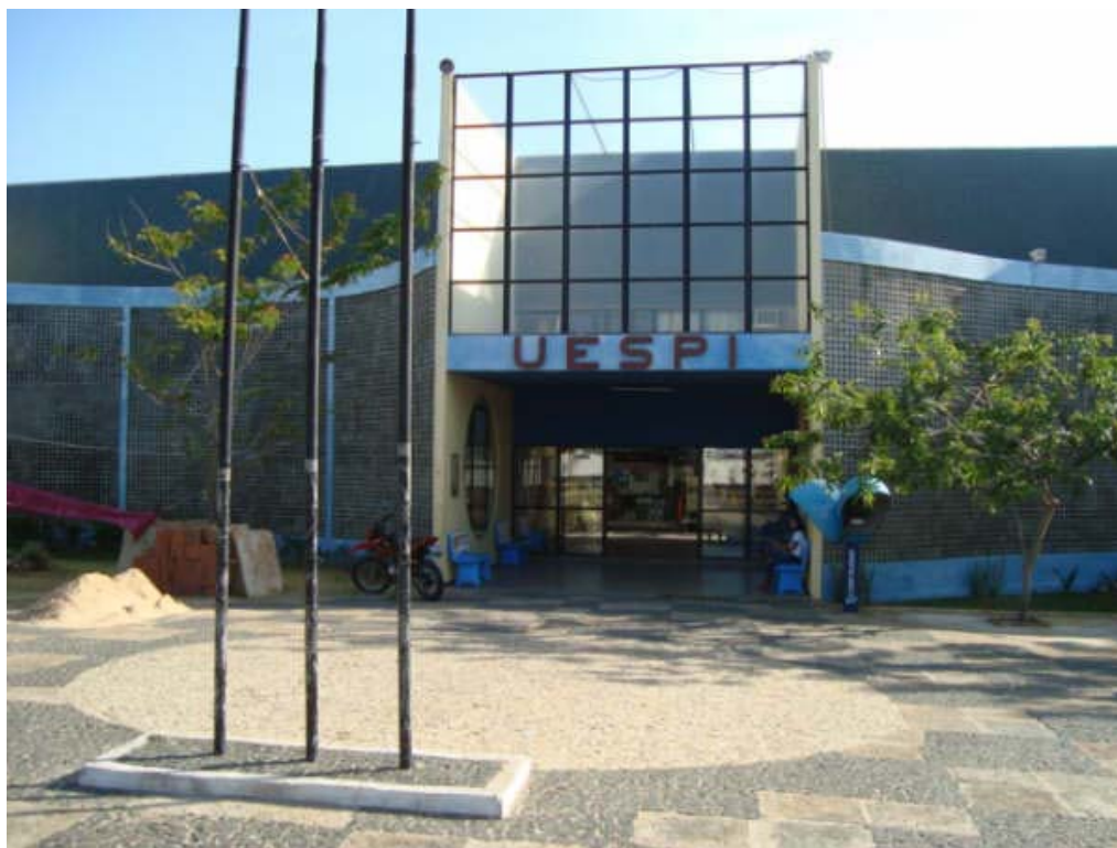
Fotografia 2: Fachada do Campus “Prof. Alexandre Alves”, UESPI, Parnaíba/PI. Fonte: ARAÚJO, Raimundo Dutra de (2009).
