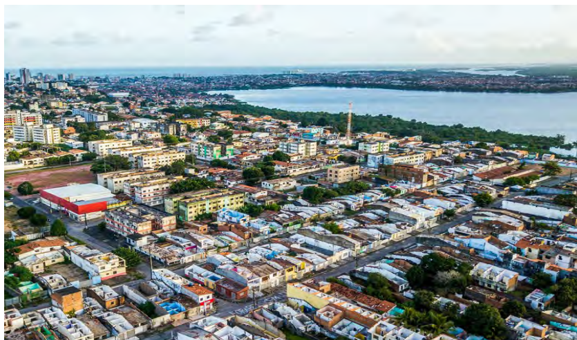
Figura 3: Foto aérea de parte da área de risco em processo de subsidência
