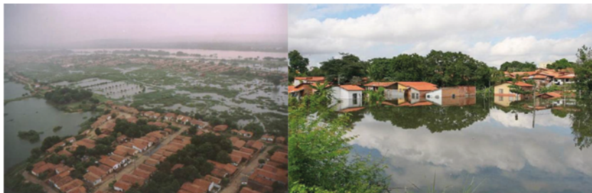
Figura 22 - Fotografias de Inundações em bairros da Região Norte de Teresina
