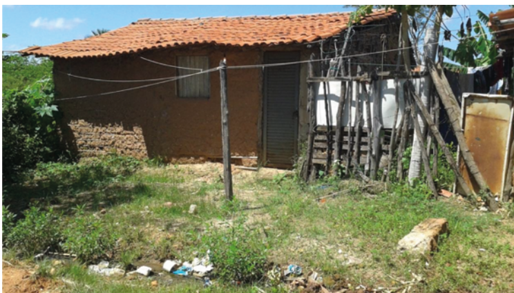
Figura 20 - Casa de taipa construída no entorno de uma lagoa atingida constantemente pela inundaç o durante o per odo chuvoso, no bairro S o Joaquim, regi o norte da cidade de Teresina
