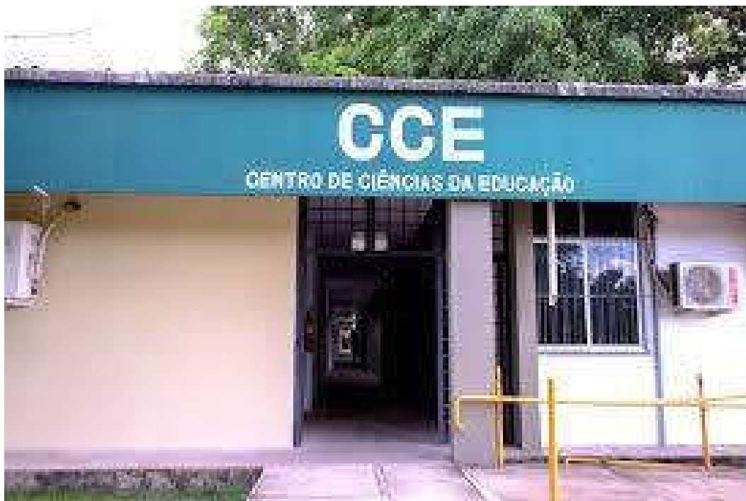
Figura 01 - Fachada do prédio do CCE
