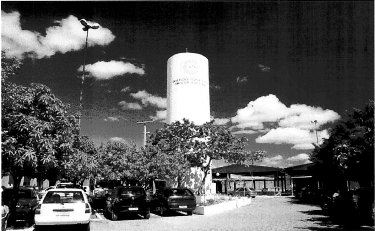
Imagem 1: Estrutura Antiga do CSHNB/UFPI (2005)
