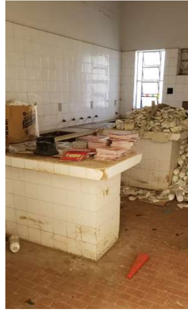
Vista interna de sala – piso cerâmico, bancadas e esquadrias a serem retirados
