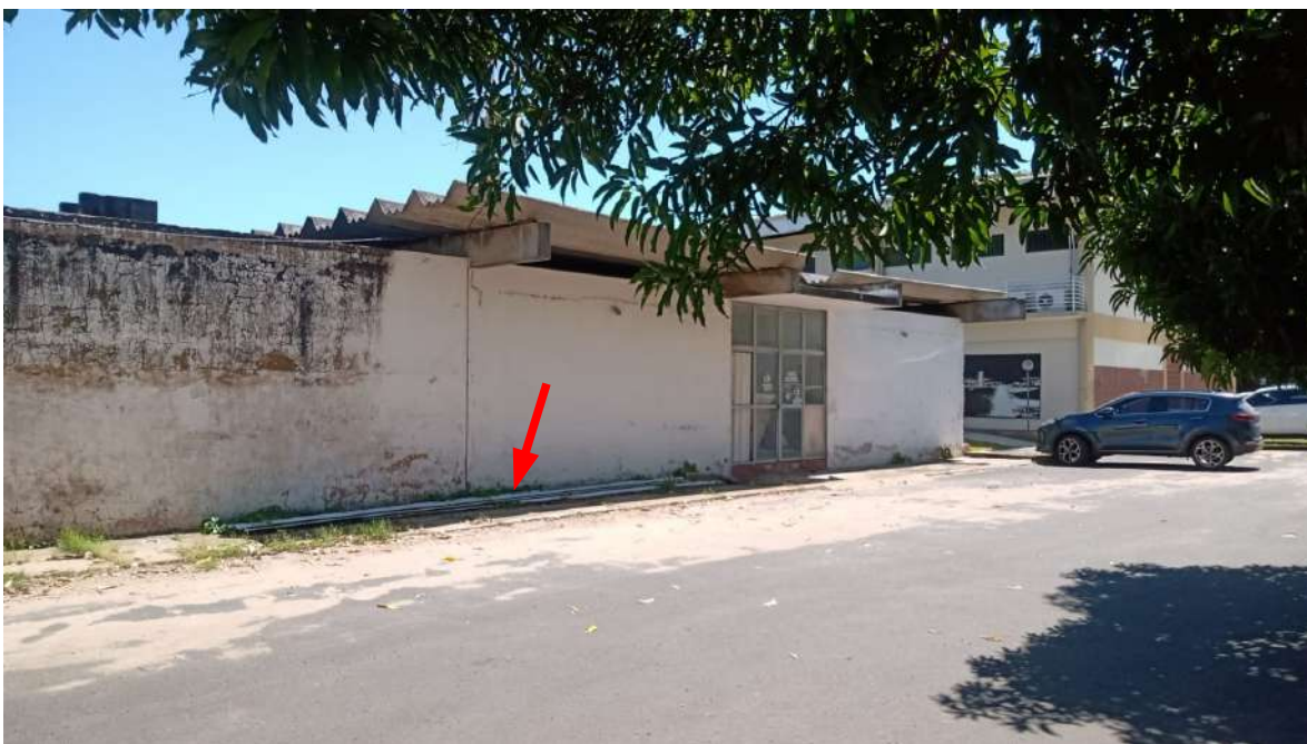
Vista Externa – refazer calçada e demolir muro
