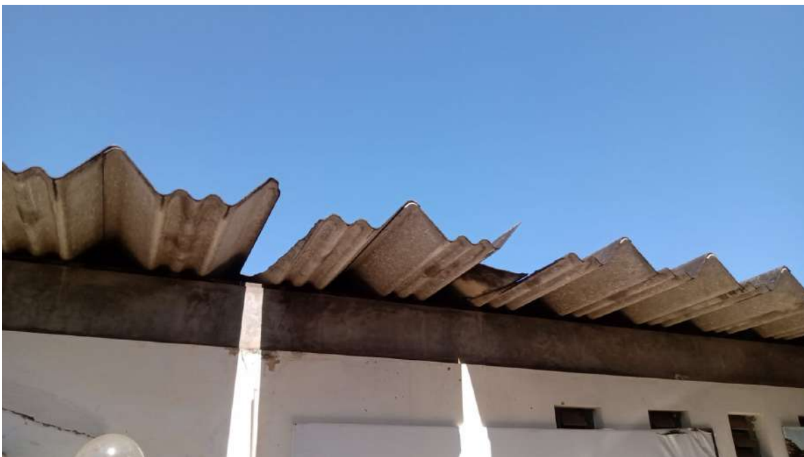
Vista da telha a ser substituída
