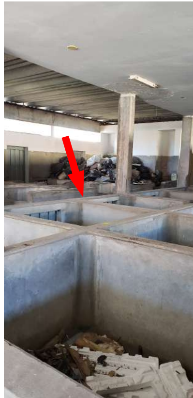
Vista interna do prédio – paredes a serem demolidas
