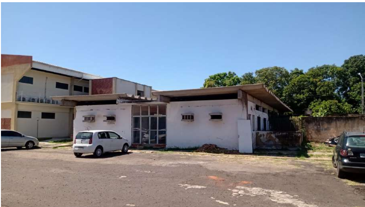
Fachada 03 – voltada para o Prédio do Juizado de Pequenas Causas
