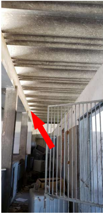
Vista interna do prédio – encontro cobertura e calha central
