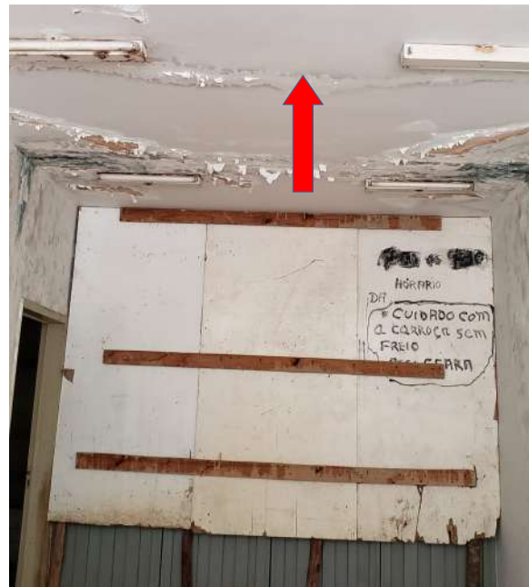
Vista interna da calha central a ser recuperada e impermeabilizada
