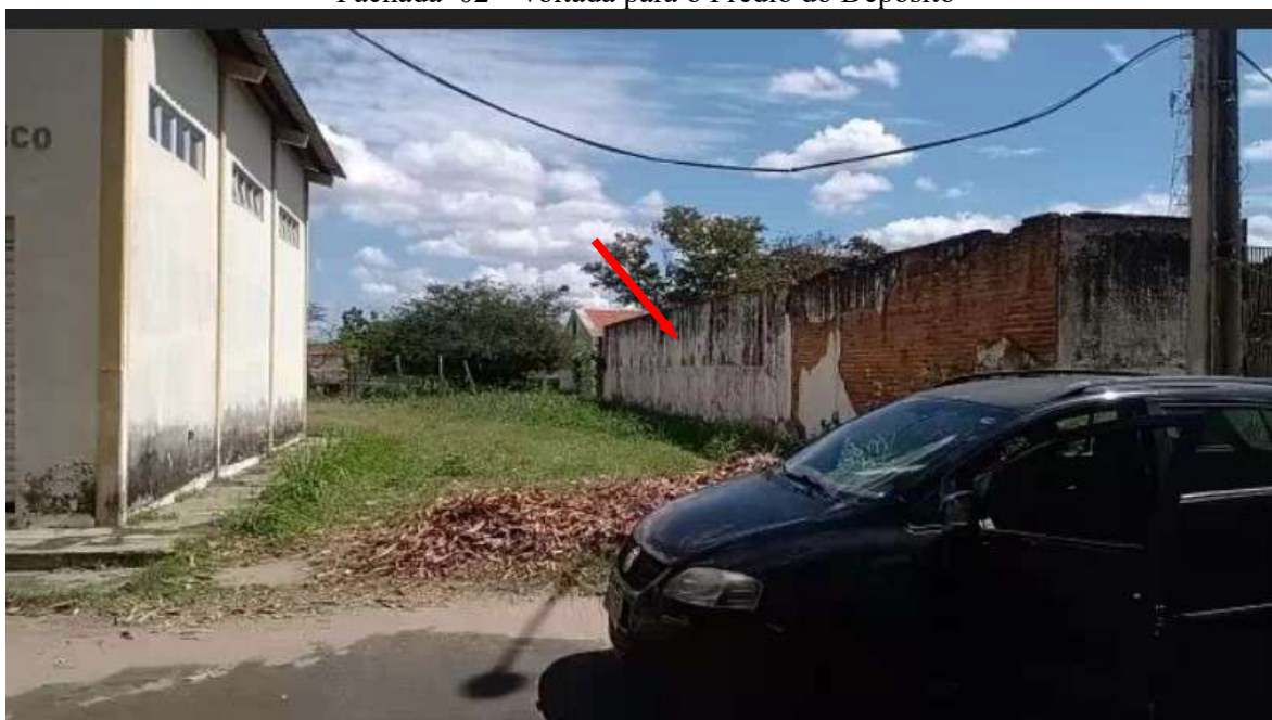
Vista do muro (a ser demolido entre a Fachada 02 e o Prédio do Depósito)
