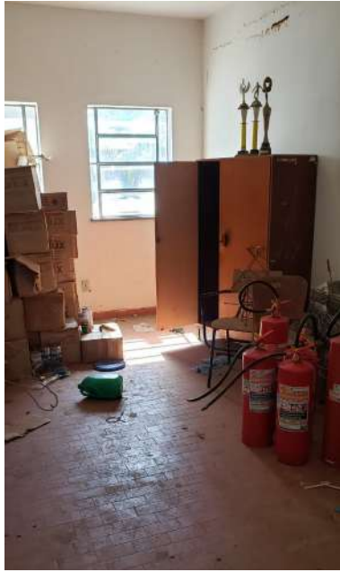
Vista interna de sala – piso cerâmico e esquadrias a serem retirados
