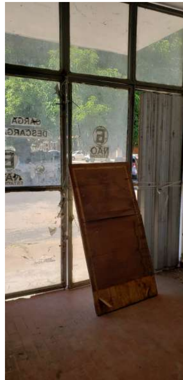
Vista interna da Porta principal a ser removida
