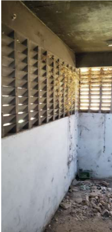
Construção anexa a ser demolida.
