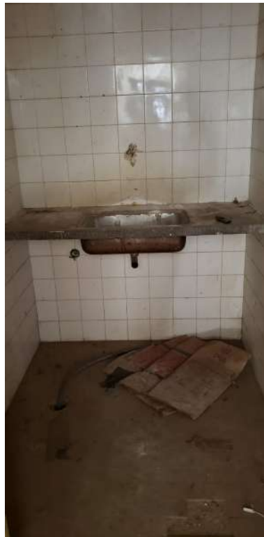
Vista interna de sala – revestimento e pia a serem retirados
