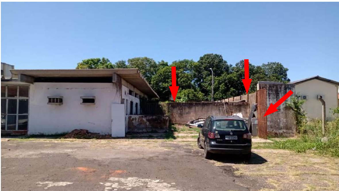
Construção anexa, muro e portão a serem demolidos
