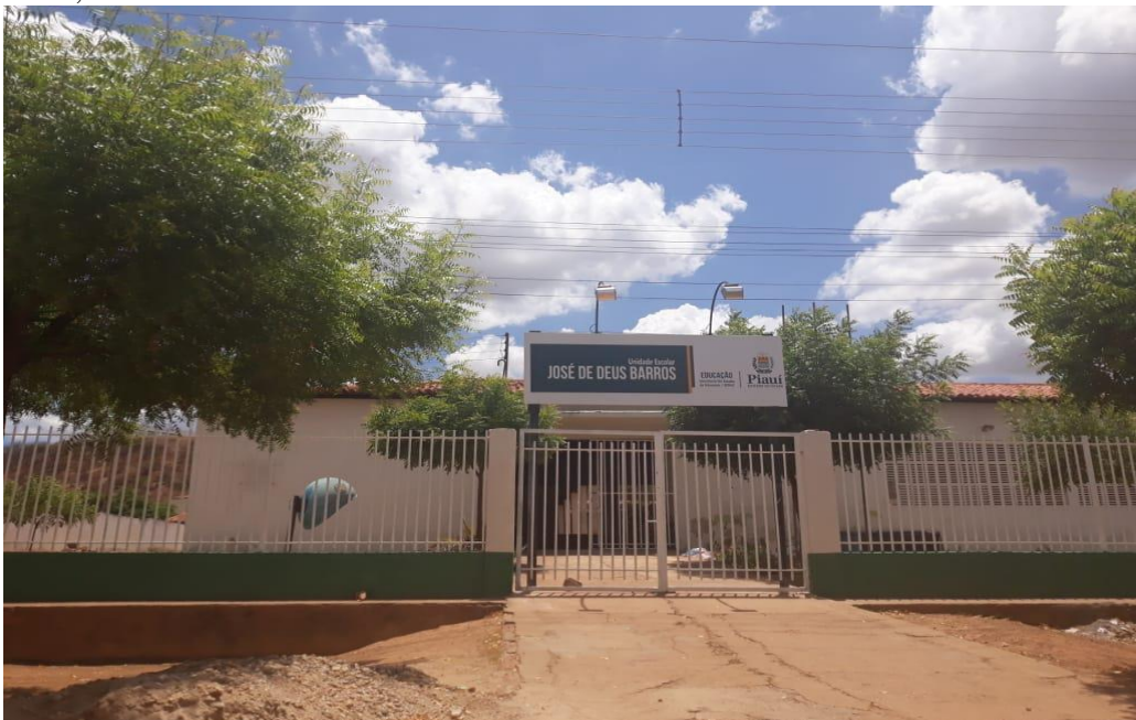
Figura 1 – Unidade Escolar José de Deus Barros localizada no Bairro Parque de Exposição, cidade de Picos, Estado do Piauí.
