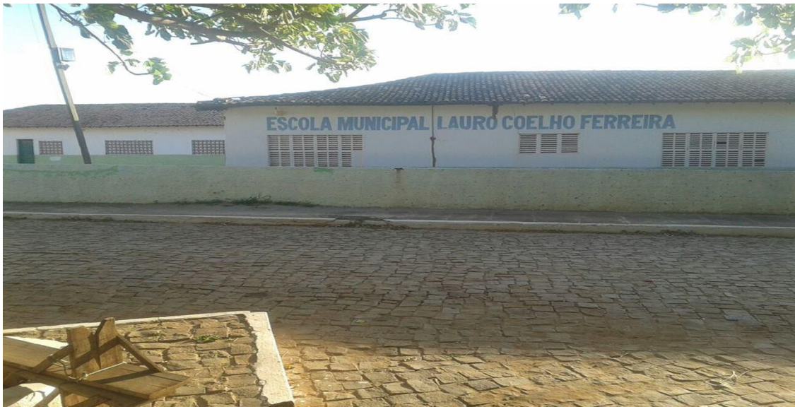
Foto 01: Fachada da Unidade Escolar Lauro Coelho Ferreira
