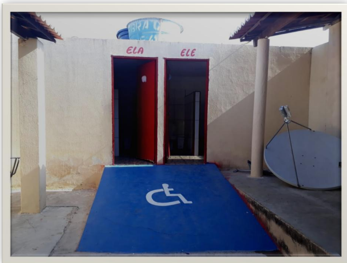
Foto 3 – Área externa dos banheiros da escola do campo investigada, 2018
