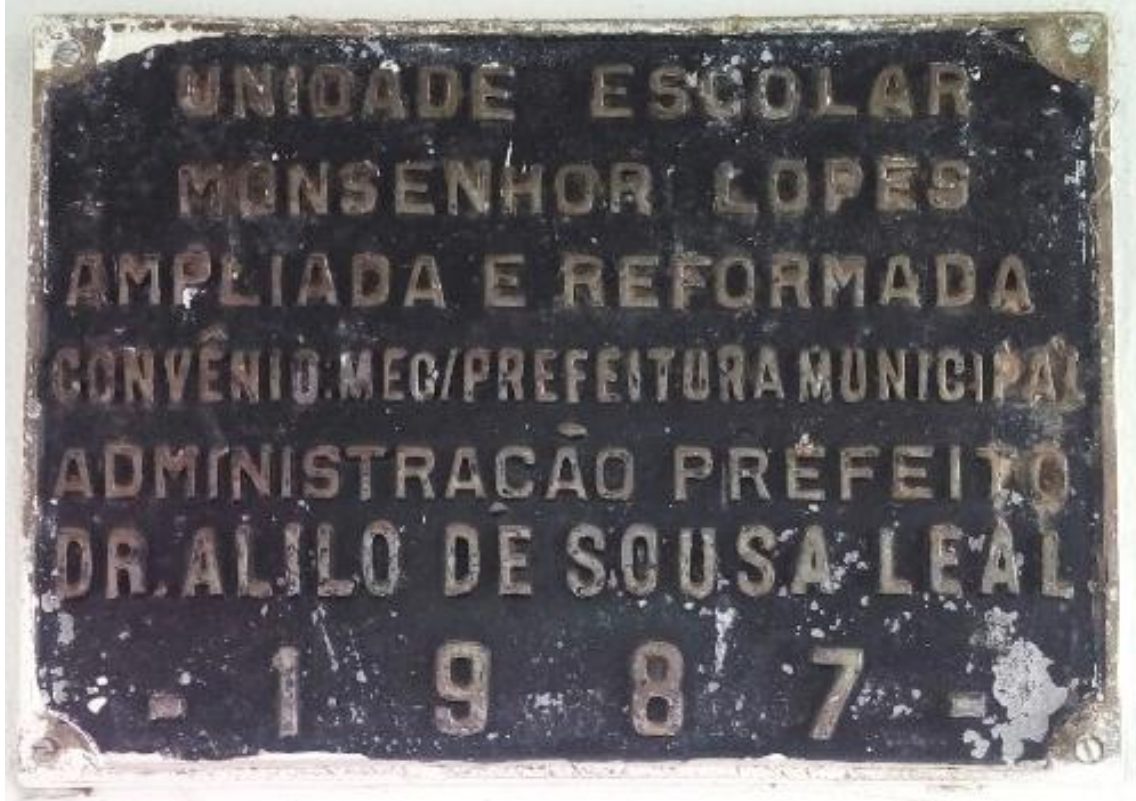
Figura 4 – Placa de ampliação e reforma da Escola Monsenhor Lopes da Comunidade Forte no ano de 1987.
