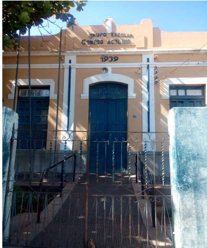
Figura 2 Unidade Escolar Cônego Acilino Arquivo: Francisca Raimunda, 2015.
