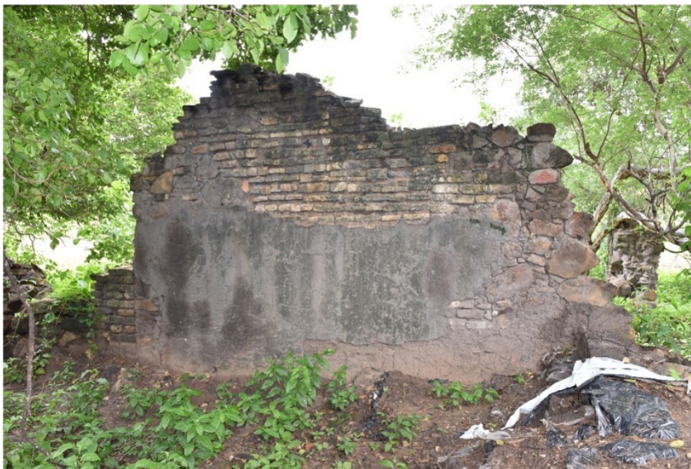
Figura 55 Alvenaria mista em tijolo, pedra e cascalho
