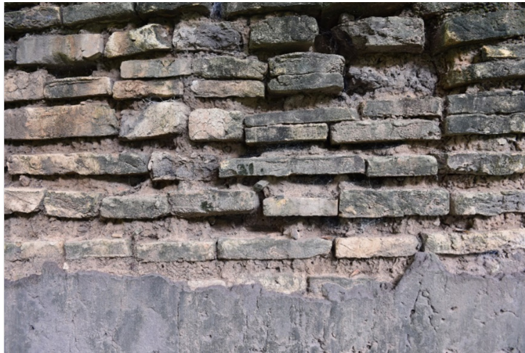
Figura 54 Alvenaria em tijolos de tamanhos variados
