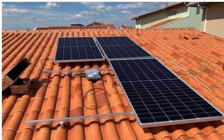
Figura 1: Microinversor instalado junto às placas fotovoltaicas.
