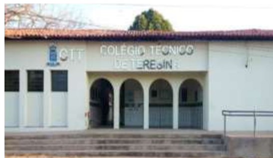
Figura 16 Fachada externa do CTT
