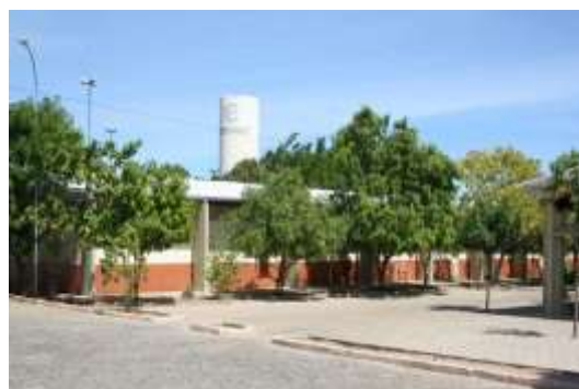
Figura 15 – Fachada externa do CSHNB, em Picos-PI
