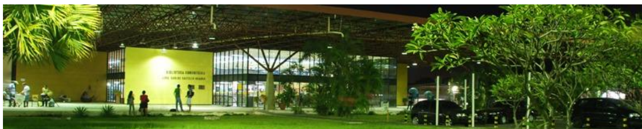
Figura 1 – Fachada da Biblioteca Comunitária
