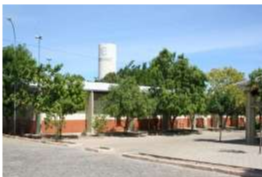
Figura 15 – Fachada externa do CSHNB, em Picos-PI
