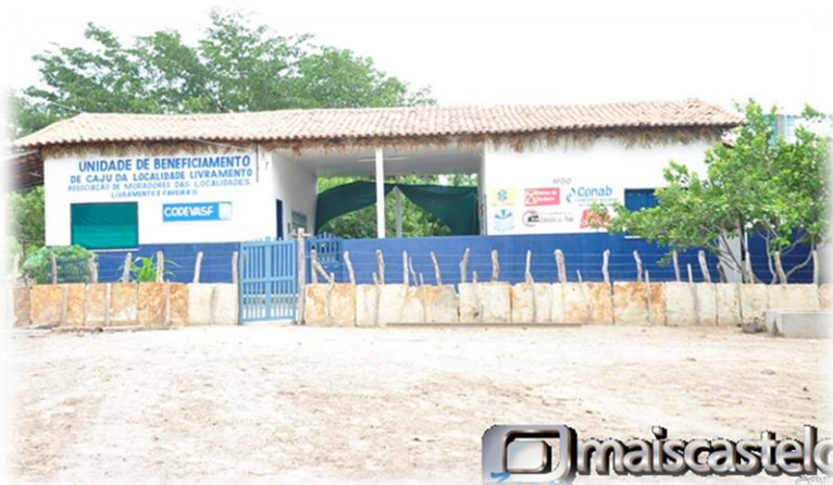
Figura 02: Unidade de Beneficiamento de caju
