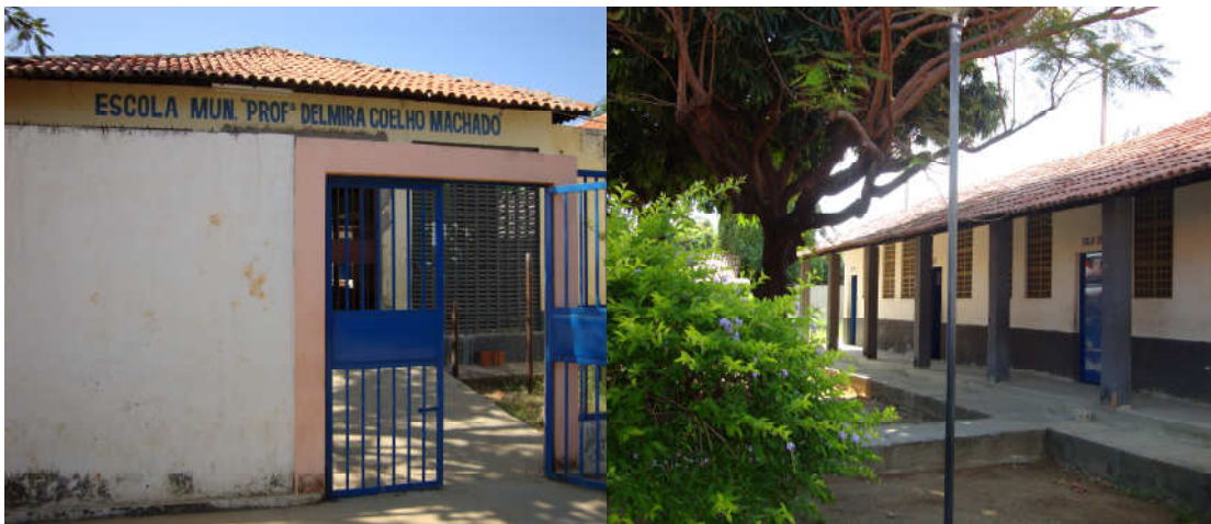
Figura 4 – Escola Municipal Delmira Coelho Machado Fonte: Acervo de Valdirene Gomes de Sousa (2009)
