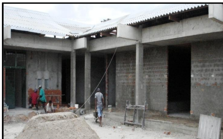
Figura 68: Obras das salas de Música da UFPI. 2008. Fonte: Acervo particular de João Valter Ferreira Filho.
