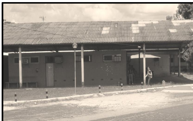
Figura 56: SG-09, pavilhão que abrigou as aulas da LCM e do CLPEA até o início da década de 1990. Fonte: Acervo particular de João Valter Ferreira Filho.
