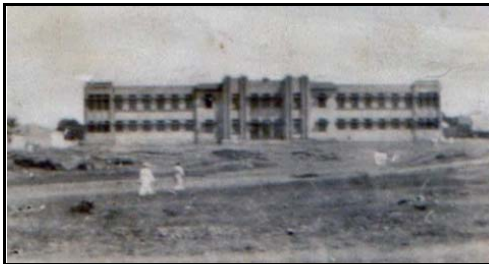
Figura 40 - Fachada do Edifício do Liceu Piauiense em construção. Fonte: FERRO, Maria do Amparo Borges (1996, p. 101).
