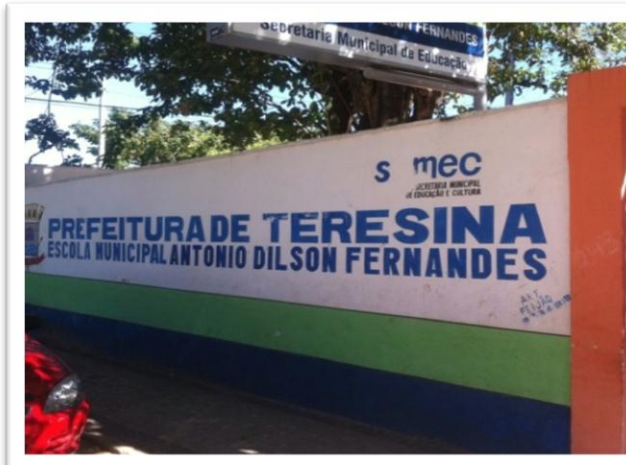
Foto 02: Fachada da escola
