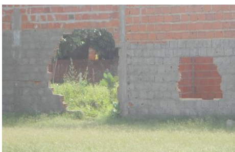
Fotografia 9: Buracos nos muros da escola
