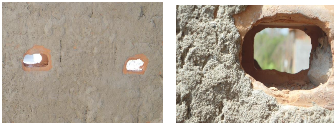
Fotografia 5: Furos nos muros da escola Fotografia 6: Furo nos muros da escola
