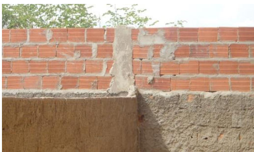
Fotografia 7: Elevação nos muros da escola
