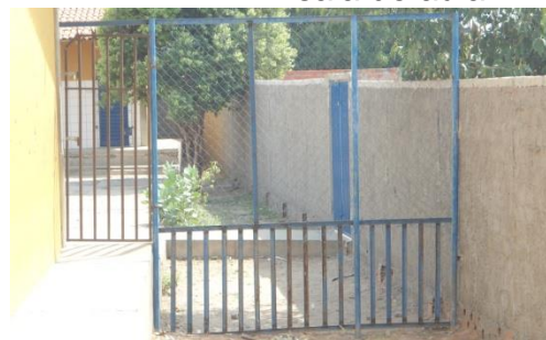
Fotografia 8: Grades entre bloco de sala de aula
