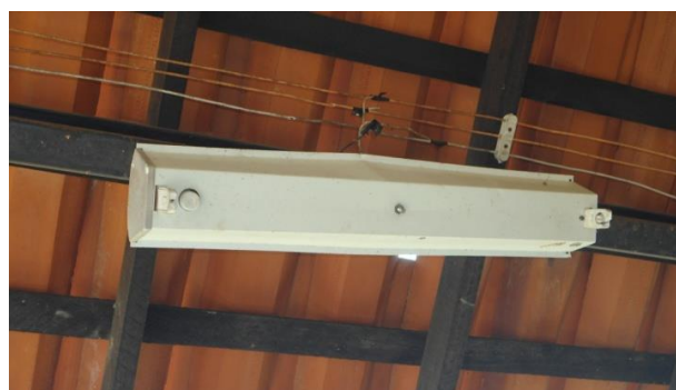
Fotografia 4: Luminárias sem lâmpadas
