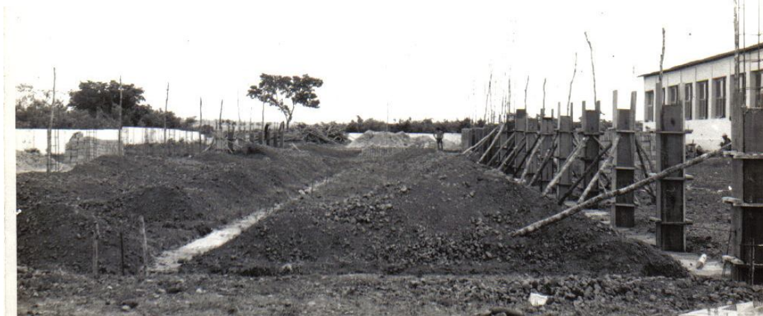
Figura 4 – Construção do Pavilhão A, em 1973.
