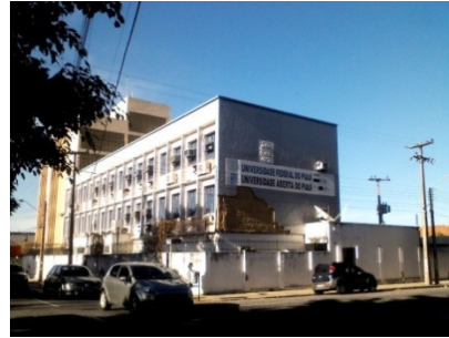
Foto atual do prédio da antiga FAFI (Faculdade de Filosofia)
